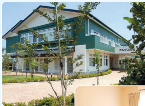
▲アルプスの杜「綾瀬」外観
