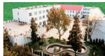
▲Alps青島教育開発センター(事務所棟、教育棟、宿泊棟)
