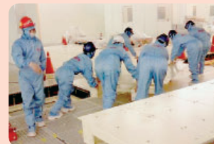
中国 成都 液晶パネル据付工事
