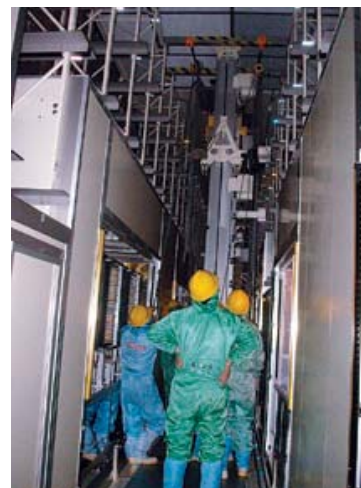
液晶パネル搬送装置の据付工事
