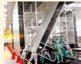
液晶パネル搬送装置の据付工事
